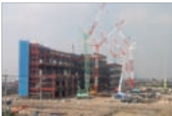
建設現場の様子 (撮影：2006年10月中旬)
