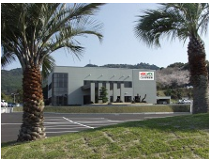
写真1: 宮之城工場 事務棟
